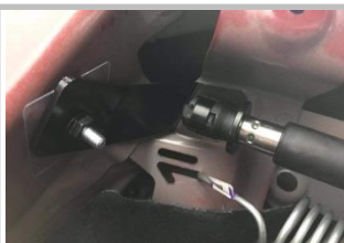
2.2 安装左上支架(完成后照片)
